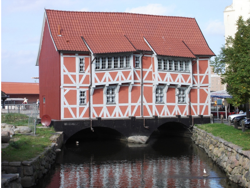
Brückenhaus in Wismar
